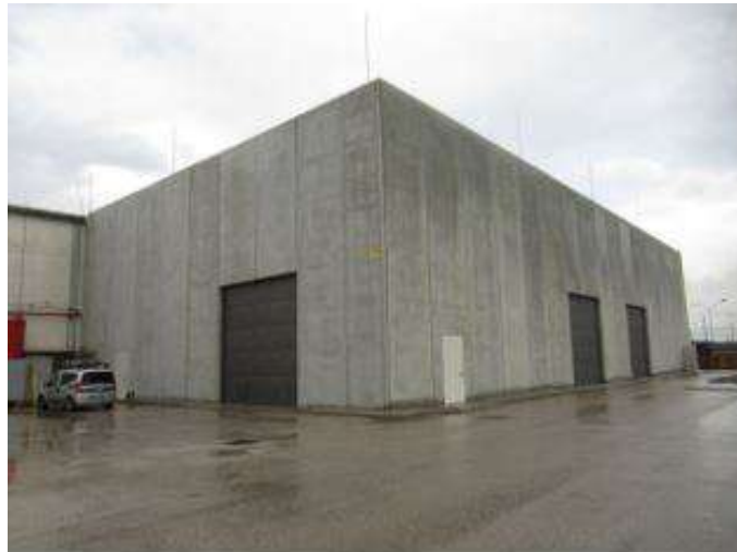
prospetti ovest e nord del nuovo capannone sub 18 visti dal piazzale comune
